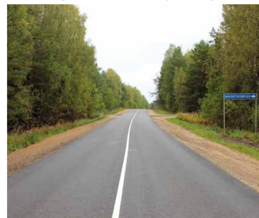
Автодорога Красномайский - Фирово после ремонта
