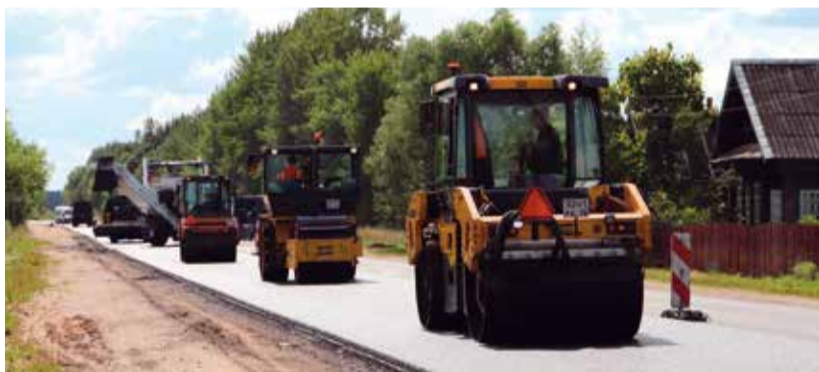
Ремонт автодороги Тверь – Бежецк – Весьегонск – Устюжна
