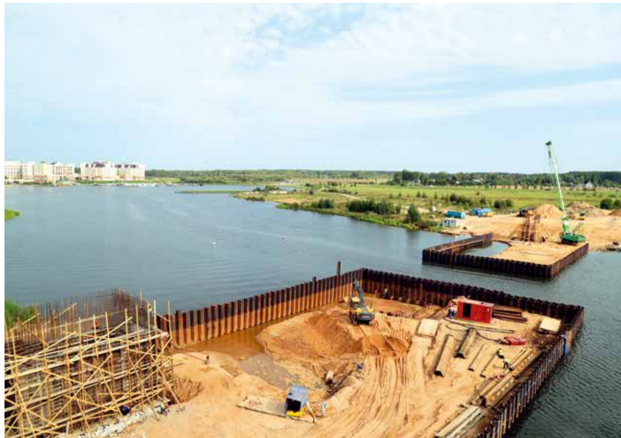
Строительство пешеходного моста через р. Дойбица
