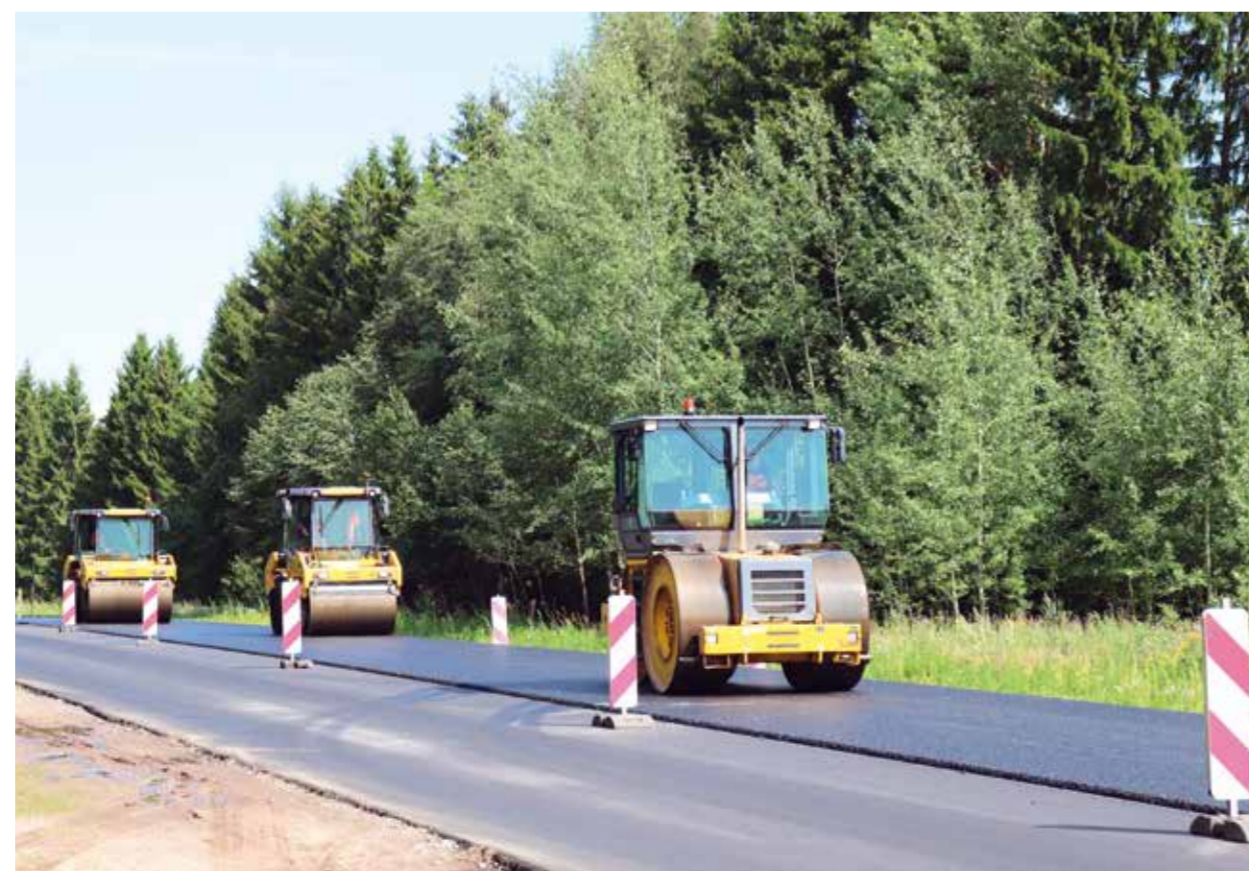
Ремонт автодороги Тверь – Бежецк – Весьегонск – Устюжна
