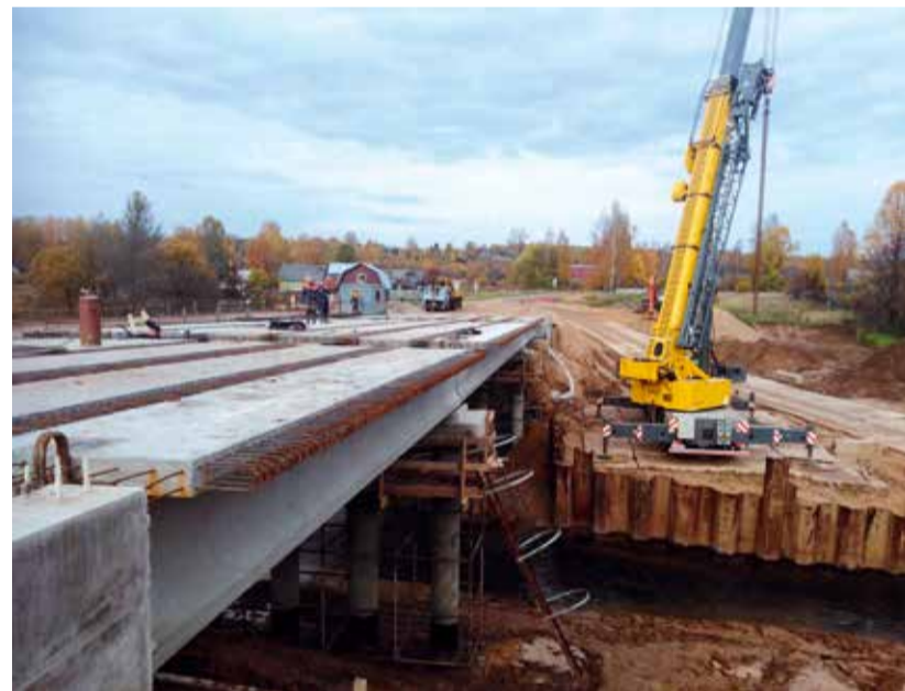
Реконструкция моста через р. Береза
