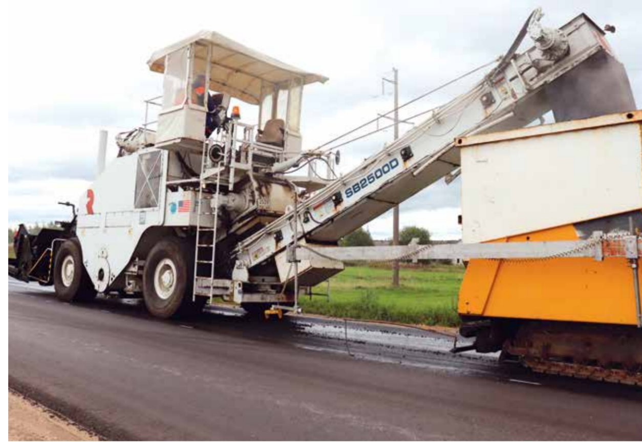
Ремонт автодороги Торжок – Осташков
