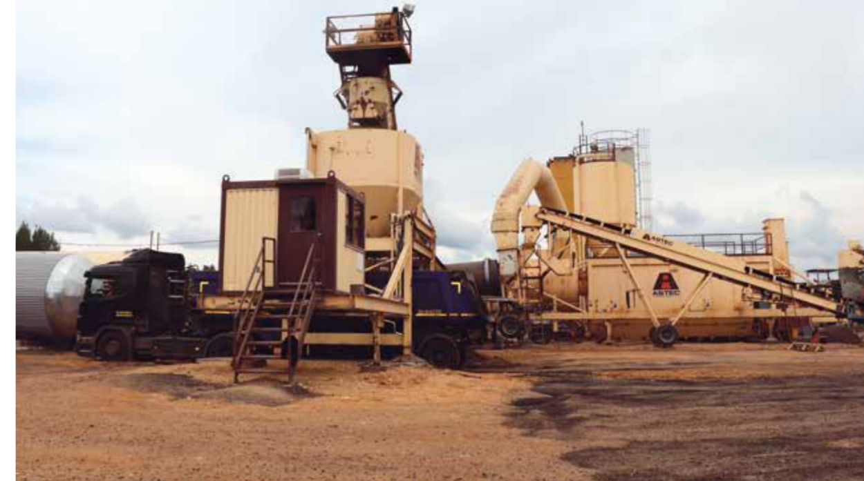
Асфальтобетонный завод подрядной организации ЗАО «АБЗ-Дорстрой»
